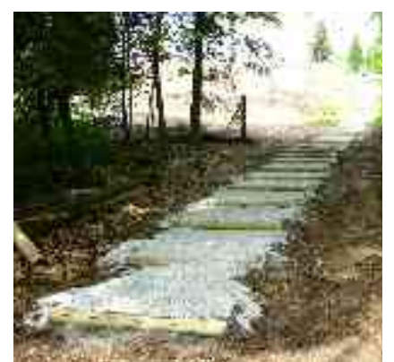
Ergebnis des 2. Arbeitseinsatzes
