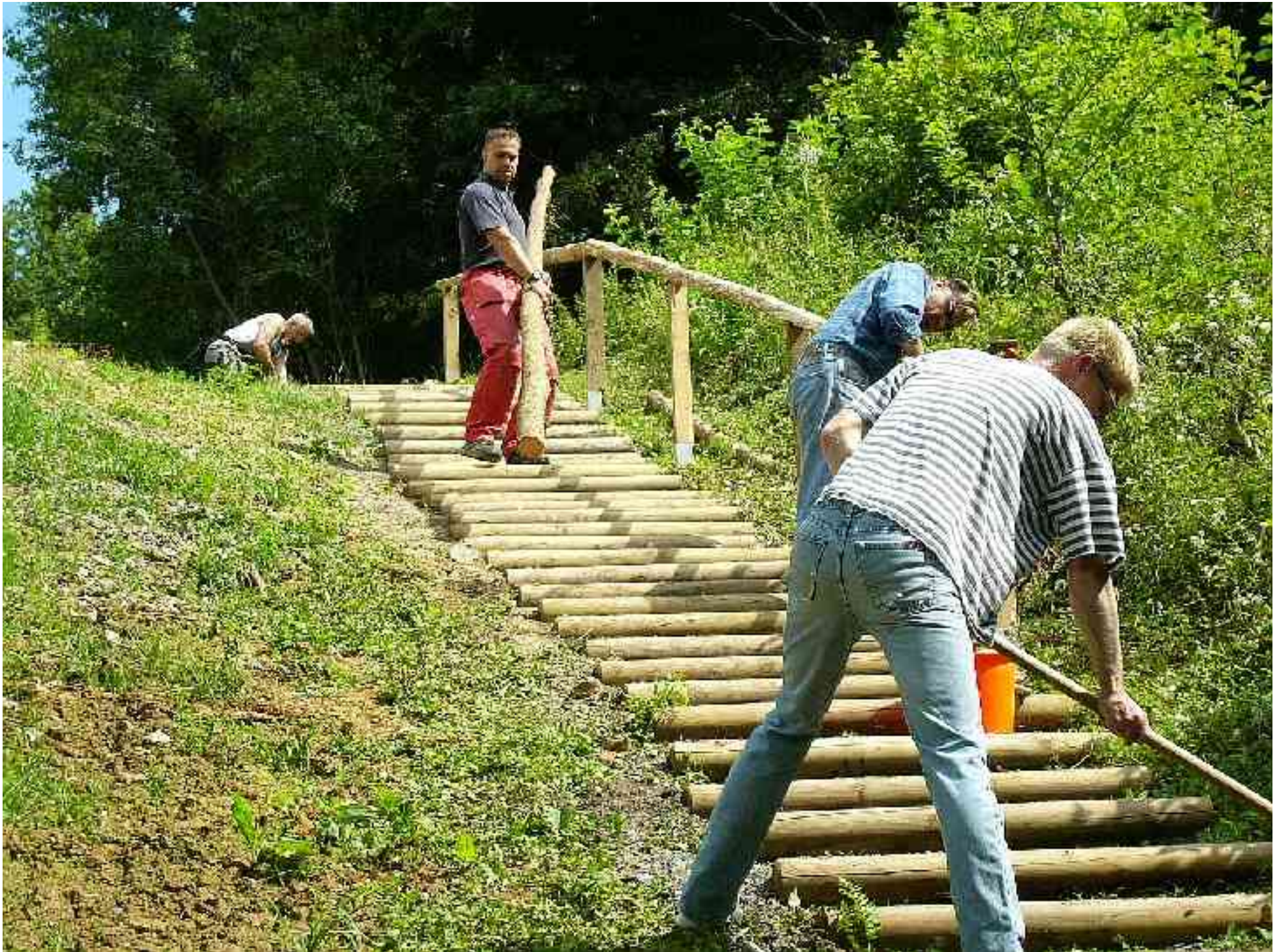
Beim dritten und letzten Arbeitseinsatz wurde das Gelände angebracht und es wurden die Schäden der starken Regenfälle der letzten Zeit beseitigt.
