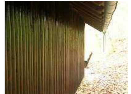
Die fertige Außenwand
