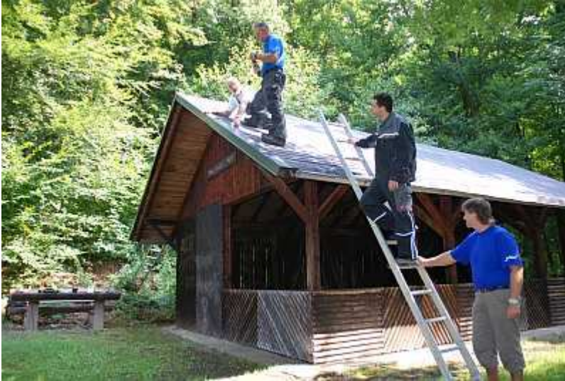
Die Helfer beim Anbringen der Ortgangbleche
