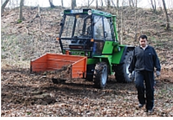
Ein erstes Teilstück für den geplanten "Panoramaweg" wird hergerichtet
